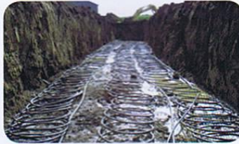
Foto 3 : Ausgrabung für geothermischen Flächenkollektor (Quelle: Eco-House)
